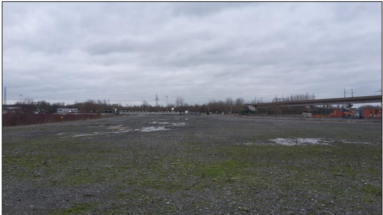
Vue du site : plateforme remblayée, graves en surface, absence de végétation
